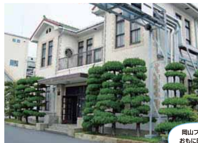
本館事務所(1915年建築)
