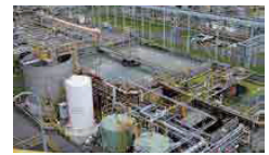
活性汚泥処理施設
